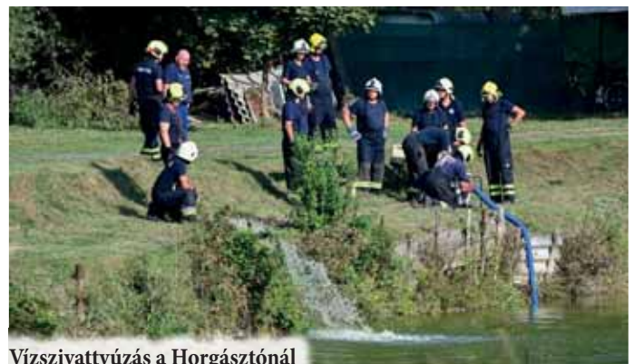
Vízszivattyúzás a Horgásztónál
